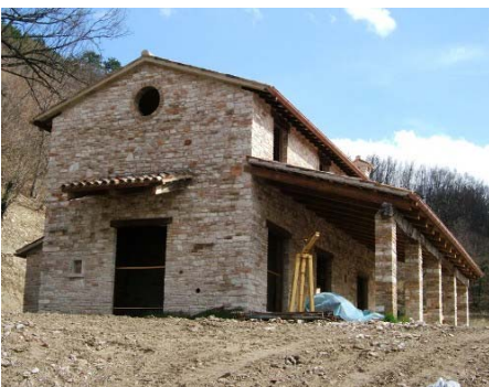
Casa Romagnola (con porticato o pergolato)
